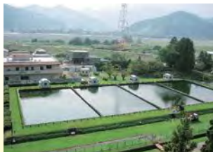
浄水場 (葵区門屋)
